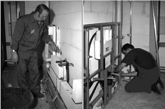
Строительство с использованием «кладки» (слева) и сухое строительство
